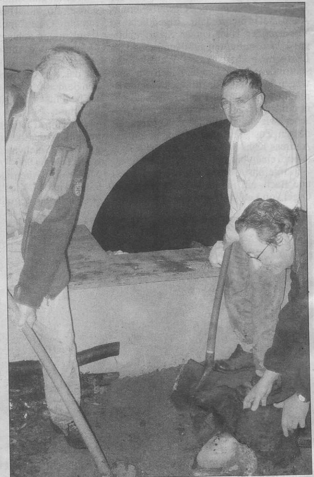
Wolfgang Eckhardt, Adam Strecker und Stefan Drott bei den Arbeiten im Hochbehälter. Bild: privat
